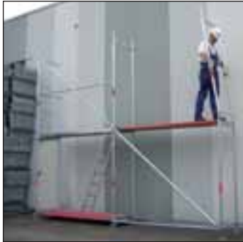
Vertikalrahmen der nächsten Lage(n) aufstecken
