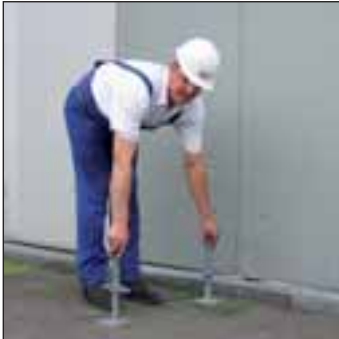
Gewindefußplatten aufstellen
