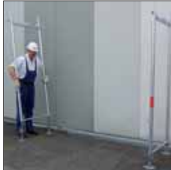
Vertikalrahmen aufstecken
